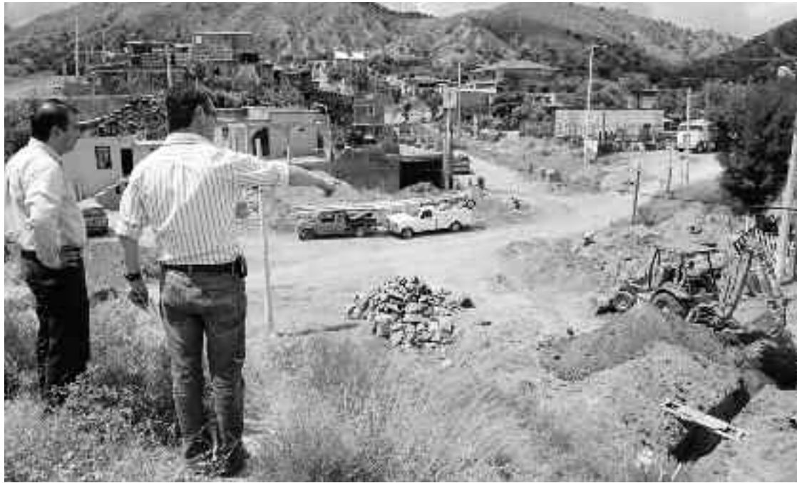
El Presidente Municipal, José Angel Hernández Barajas realizó un recorrido para supervisar las obras en diferentes colonias.
